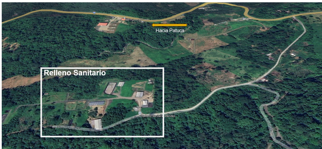
IMAGEN 44.- RELLENO SANITARIO DEL CANTÓN SANTIAGO.
