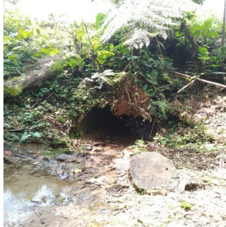
IMAGEN 32.- DRENAJE VIAL EN MAL ESTADO, PATUCA.
