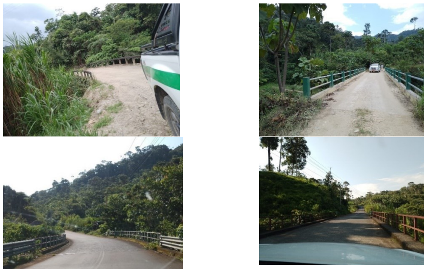
IMAGEN 35.- DRENAJE TRANSVERSAL (PUENTES) EN BUENAS CONDICIONES DE OPERACIÓN, PATUCA. Fuente: Información levantada en campo por el equipo consultor PDOT 2024. Elaboración: Equipo Consultor PDOT 2024.
