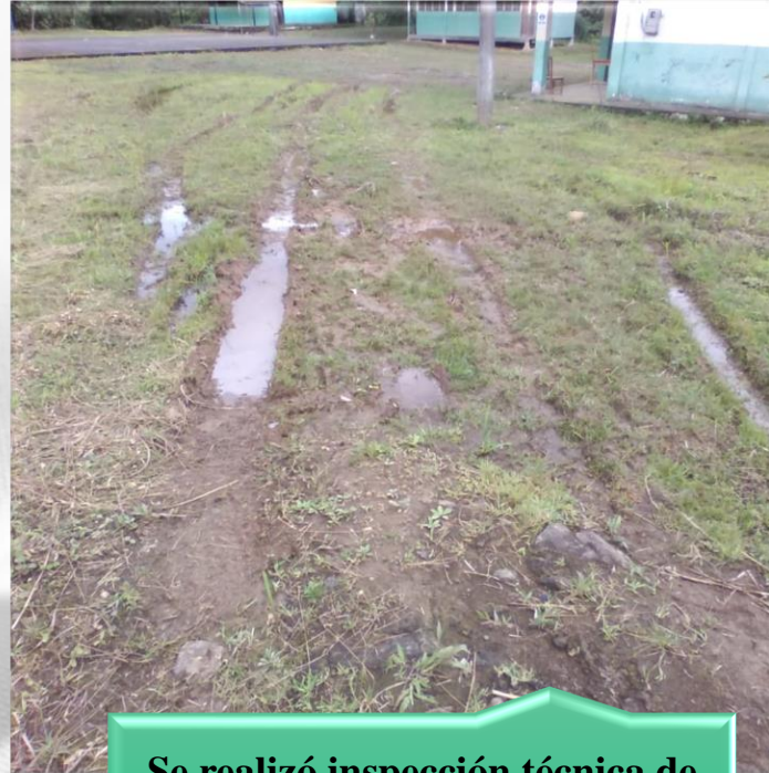
Se realizó inspección técnica de metraje y para mantenimiento de vía de escuela CECIB CHIRIAP y arreglos de y reparación de aulas
